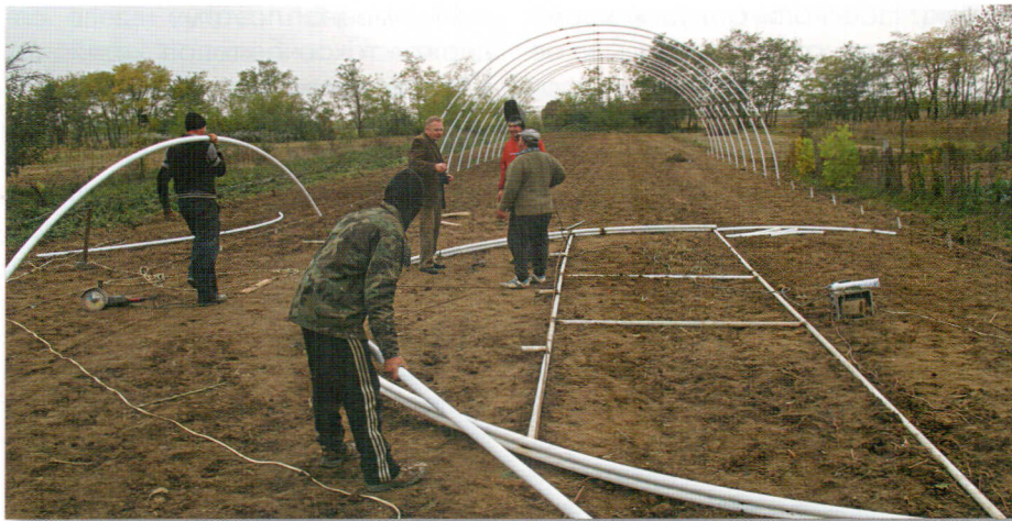
Сотрудники Центра «Terra Dei» возводят очередную теплицу
